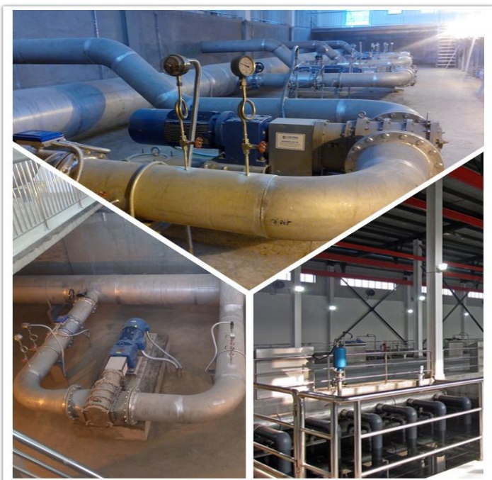
江苏南京污水厂 MBR 车间，中水回用 10 万吨/天 安装 16 台 430 方/小时罗博思达转子泵
