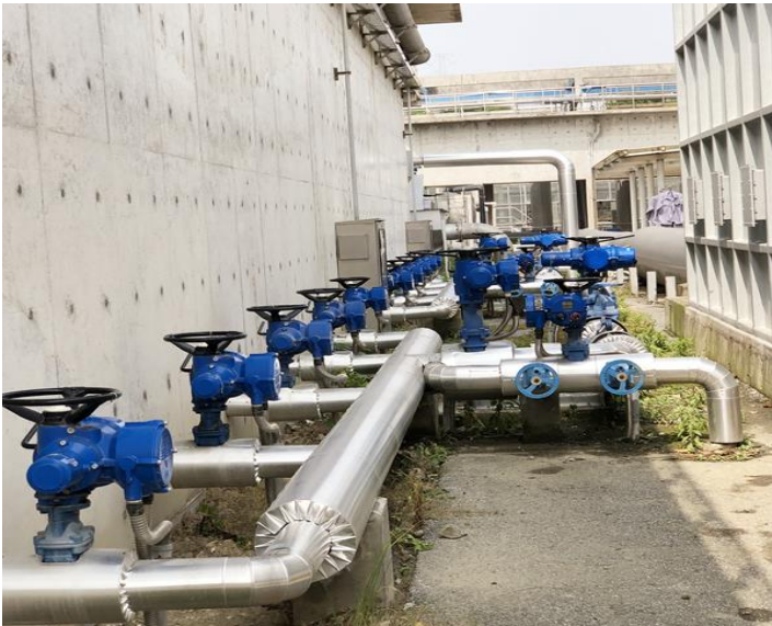
苏州污水厂 20 万吨/天 38 台 100-200 方/小时污泥转子泵，及 10 台细格栅抽砂转子泵； 65 套电动闸阀及 10 套控制柜；运行时间 2019 年 12 月，运行至今无维修记录
