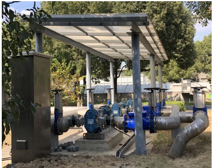
苏州污水厂 20 万吨/天 38 台 100-200 方/小时污泥转子泵，及 10 台细格栅抽砂转子泵； 65 套电动闸阀及 10 套控制柜；运行时间 2019 年 12 月，运行至今无维修记录
